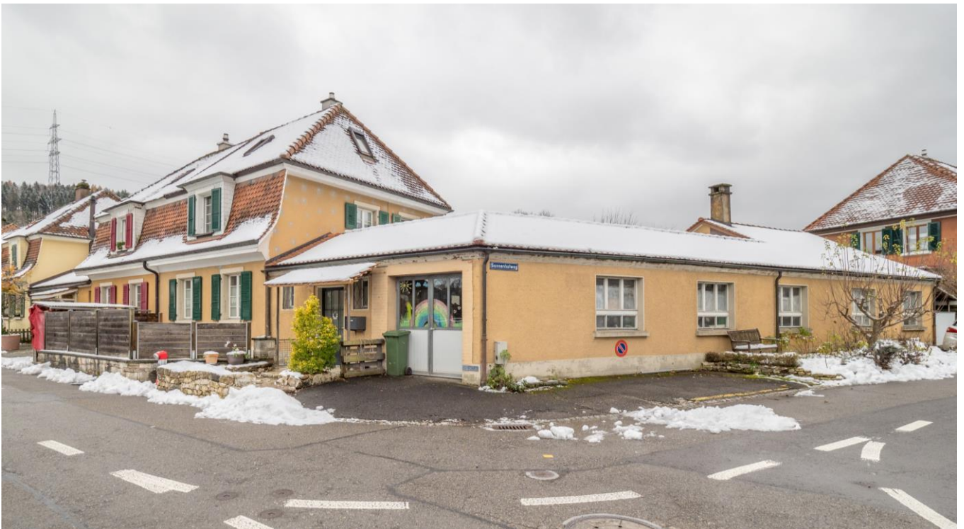
Renoviertes Doppelfamilienhaus mit grosszügigem Atelier
