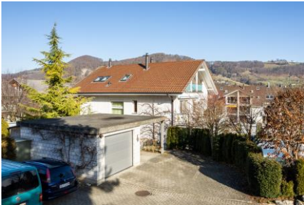
Vorplatz, Garage und Unterstand
