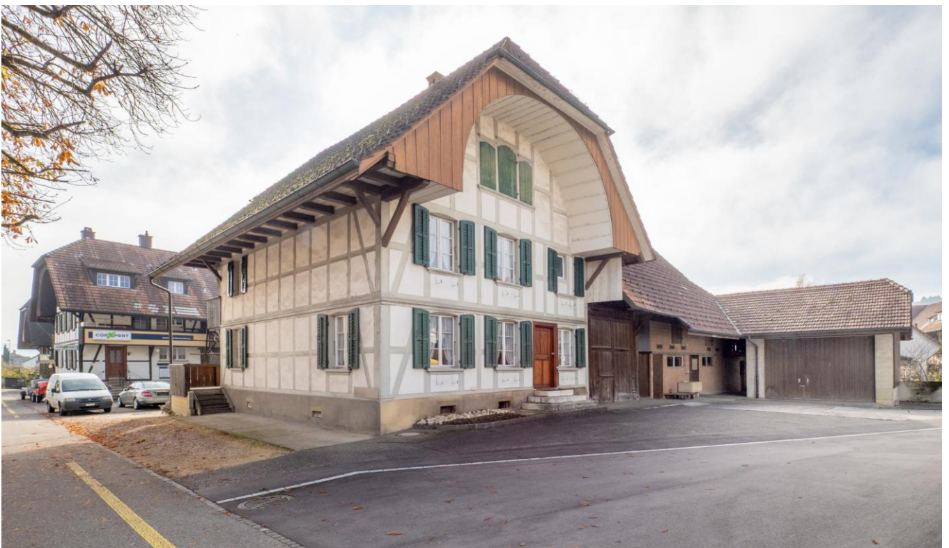
Ehemaliges Bauernhaus an zentraler Lage
