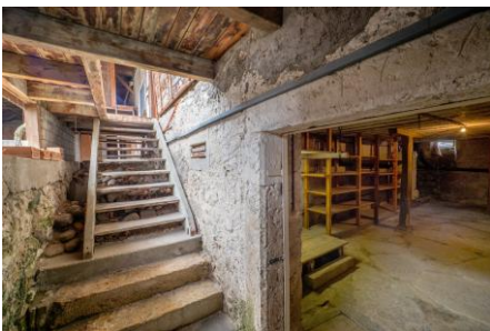
Treppe in Keller unter Wohnteil
