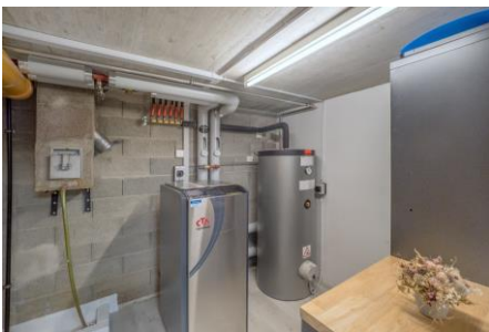
Technikraum; Erdsonden-Wärmepumpe (2023)
