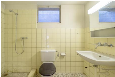
Dusche/WC im Untergeschoss
